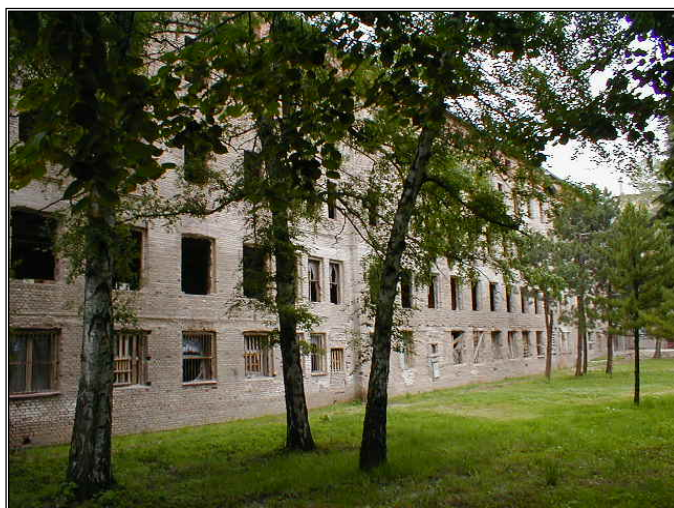
Slika 16. Devastirana zgrada Fakulteta u Zagrebačkoj 18
