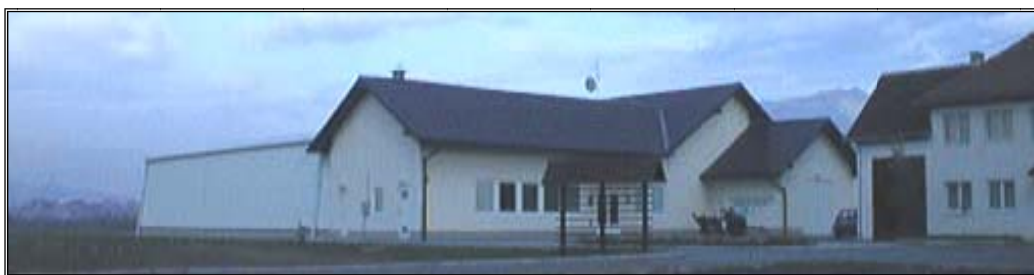
Slika 41. Obnovljeni objekat Laboratorije za poljoprivredne mašine (Foto S. Škaljić)
