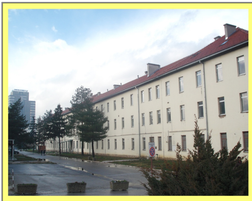
Slika 12. Zgrada u koju je nakon adaptacije Fakultet preseljen u septembru 2008. godine
