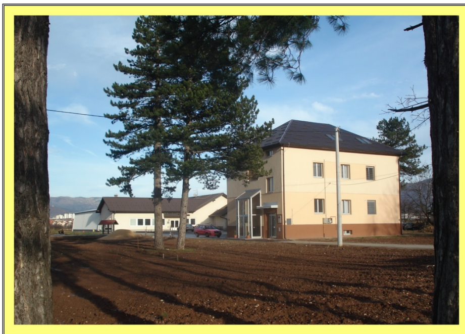
Slika 83. Zgrada Centra za biljne genetske resurse – Gen banke na Butmiru
